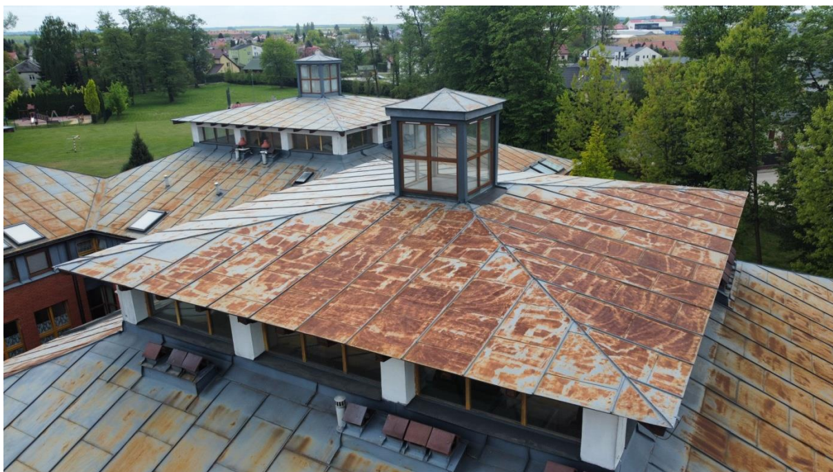
Zdjęcie Nr 3 Wieżyczki oraz pasy pionowe pod połacią główną dachu Specjalnego Ośrodka Szkolno- Wychowawczego w Zamościu .
