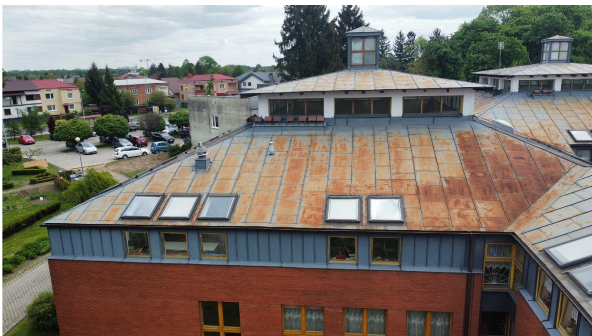
Zdjęcie Nr 4 Pasy pionowe pod połacią główną dachu wraz z wieżyczkami Specjalnego Ośrodka Szkolno- Wychowawczego w Zamościu .
