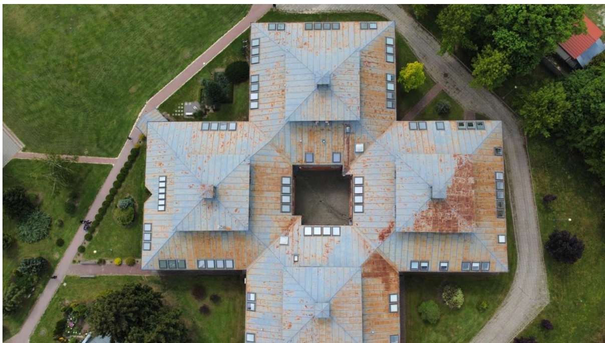
Zdjęcie nr 1 Całościowa połać dachu głównego Specjalnego Ośrodka Szkolno- W ychowawczego w Zamościu.
